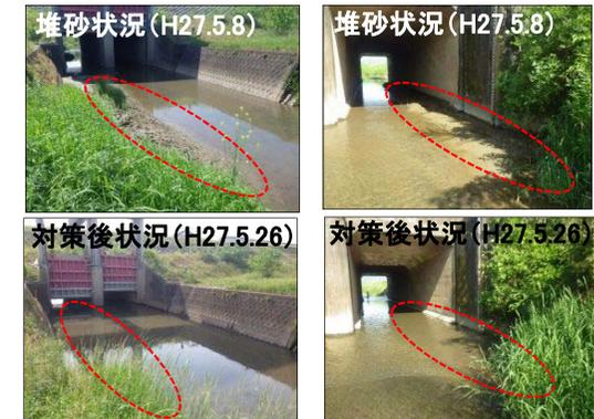
点検による樋門の堆砂状況の確認と対策後の状況
