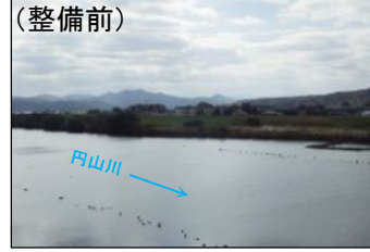
⑤立野大橋上流 緩傾斜化、半閉鎖型
