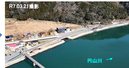
①県道橋施工後
