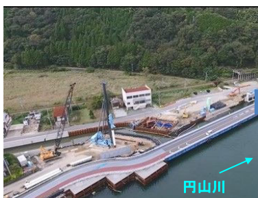
①県道橋施工前
