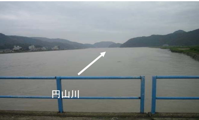
② 掘削予定箇所 (城崎大橋より上流を望む)
