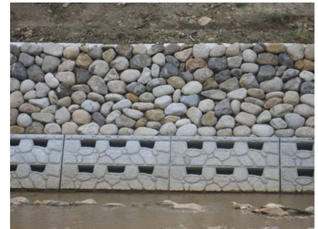
空隙の多い護岸〔魚巣ブロック〕
