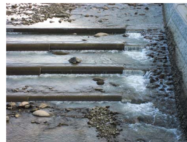
緩傾斜階段式落差工
