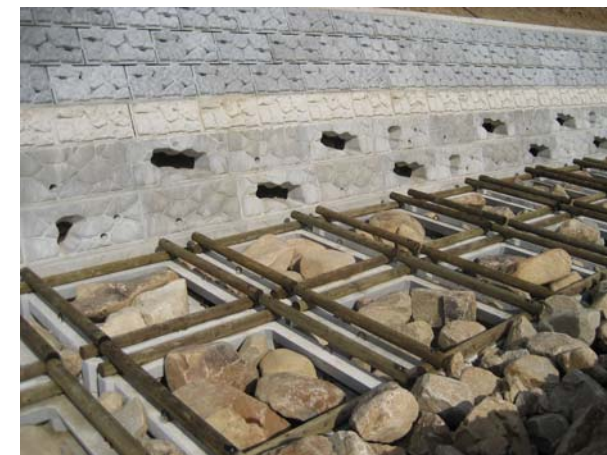
湧水を取り込む護岸構造
