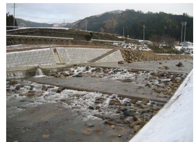
緩傾斜階段式落差工
