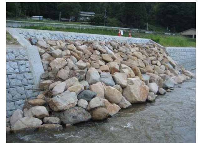
空隙のある護岸〔巨石積み護岸〕
