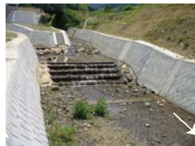
水叩・落差工 (550-6)
