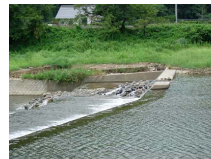
中川堰の改良状況
