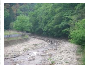
榎見橋より下流を望む (・河床は小～中礫である ・護岸によって山裾とは不連続であるが、樹木がオーバーハングしている)
