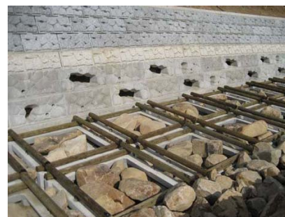
湧水を取り込む護岸構造
