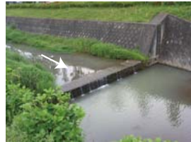
落差工 (277) (堰・落差工の落差は大きくても 0.5m程度である)
