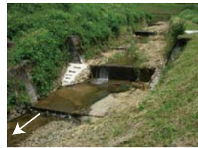
水叩・落差工 (541)
