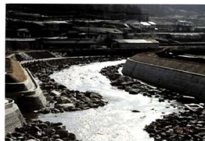
多自然型川づくりによる復旧工事直後の川の様子（平成6年10月）
