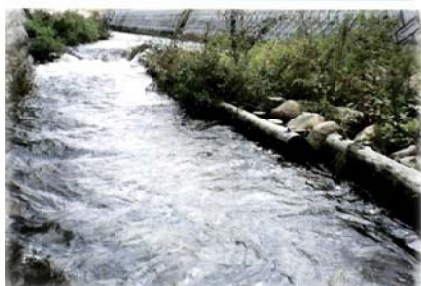
枠組み護岸工（ネコヤナギの植栽）
