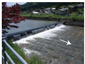
日向井堰 (424) (ゴム堰が起立している時は魚道に通水がある)
