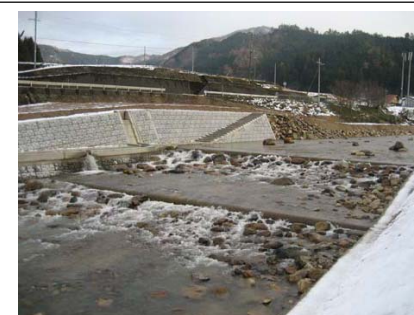
緩傾斜階段式落差工
