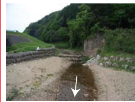
床止め (273-1) (出石川との合流点に根固ブロック が設置されている)
