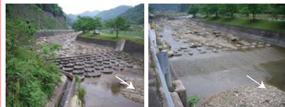
丸山堰 (315) (緩い斜路やテーブル状の落差工が見られる) 落差工 (316)
