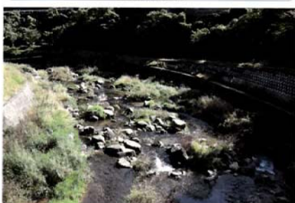
巨石の再配置
