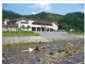
右岸より下流を望む (河床は砂〜大礫が中心である。 親水護岸が整備されている)
