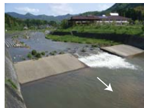
落差工 (412) (落差の大きい落差工には階段状の魚道が設置されているが、プールが無いものは魚類の遡上は難しい)
