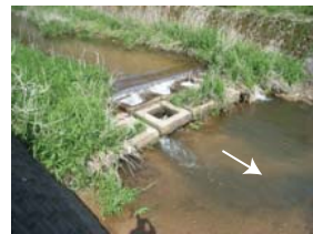
床止め工・落差工 (440) (太田川上流は根固ブロックによる落差が大きい)
