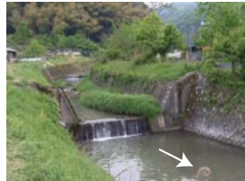
落差工 (277) (堰・落差工の落差は大きくても 0.5m程度である)
