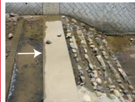
水叩・落差工 (548-3)
