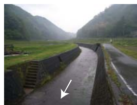
右岸より上流を望む (上流は三面張り水路となる)
