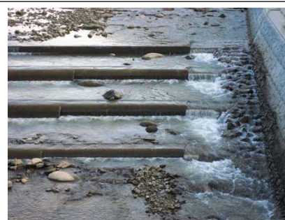
緩傾斜階段式落差工
