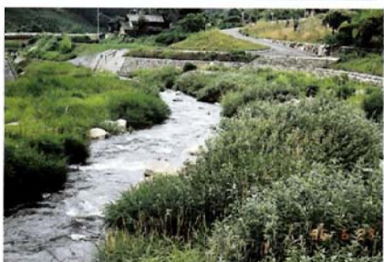
枠組み護岸工（ネコヤナギの植栽）
