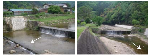
八王子堰 (309) (下流は落差工が 0.5m 程度の横断構造物が点在するため、遡上が難しい) 下の谷堰 (311)
