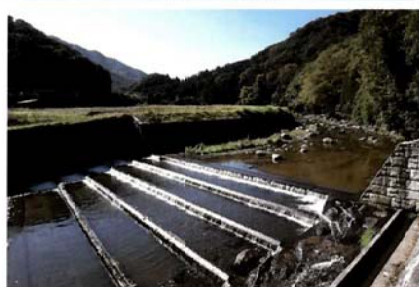
全面多段式落差工
