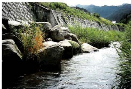
沈床集穴工
