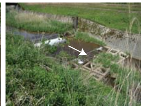
床止め工・水叩・落差工 (442)
