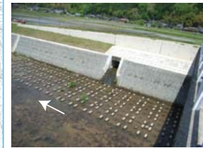
右流入水路 (流入水路と川の落差は大きい)
