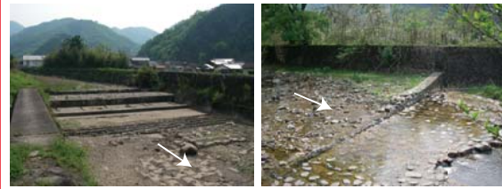
落差工 (307) (出石川との合流点から 307-1 無水区間となっている) 堰 (307-1)
