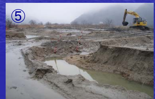
⑤ 工事箇所の土砂
