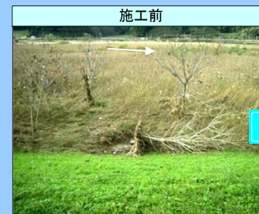
出水直後の状況 (2004.11.02)
