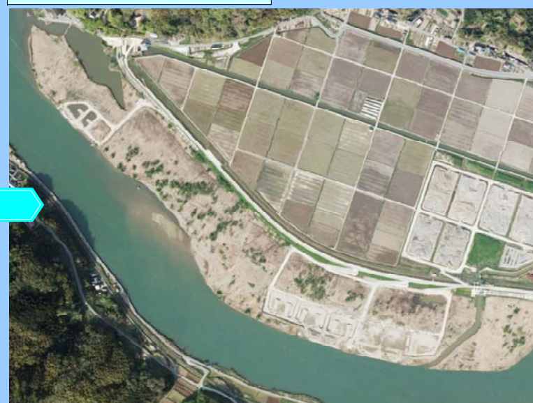
写真-2 工事中(平成21年撮影)
