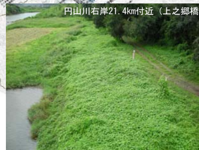
円山川右岸21.4km付近（上之郷橋）
