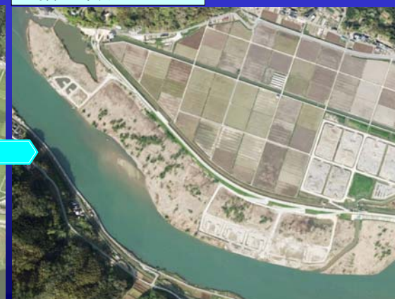
写真-2 工事中(平成21年撮影)
