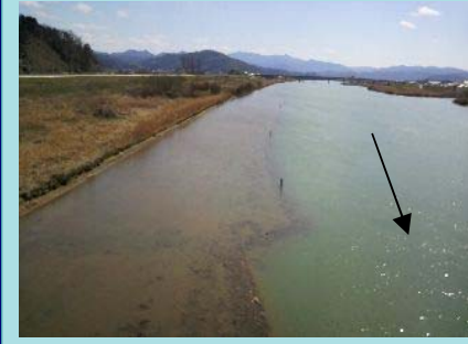
12.4～12.6k付近の高水敷きの状況
