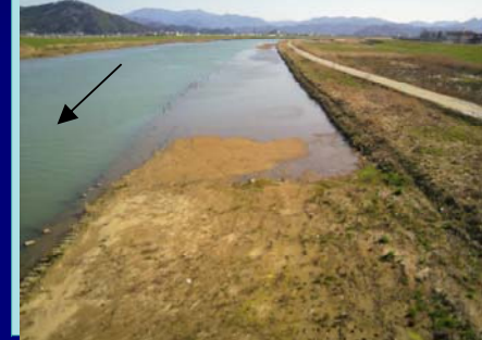
13.2k付近の高水敷きの状況
