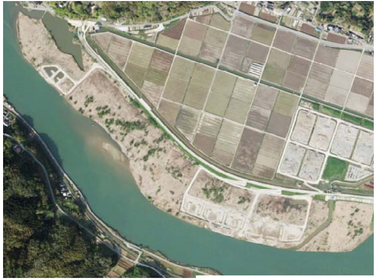
工事中(平成 21 年撮影)
