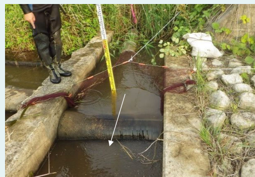
魚道出口や落差工上部の滞筋などに設置
