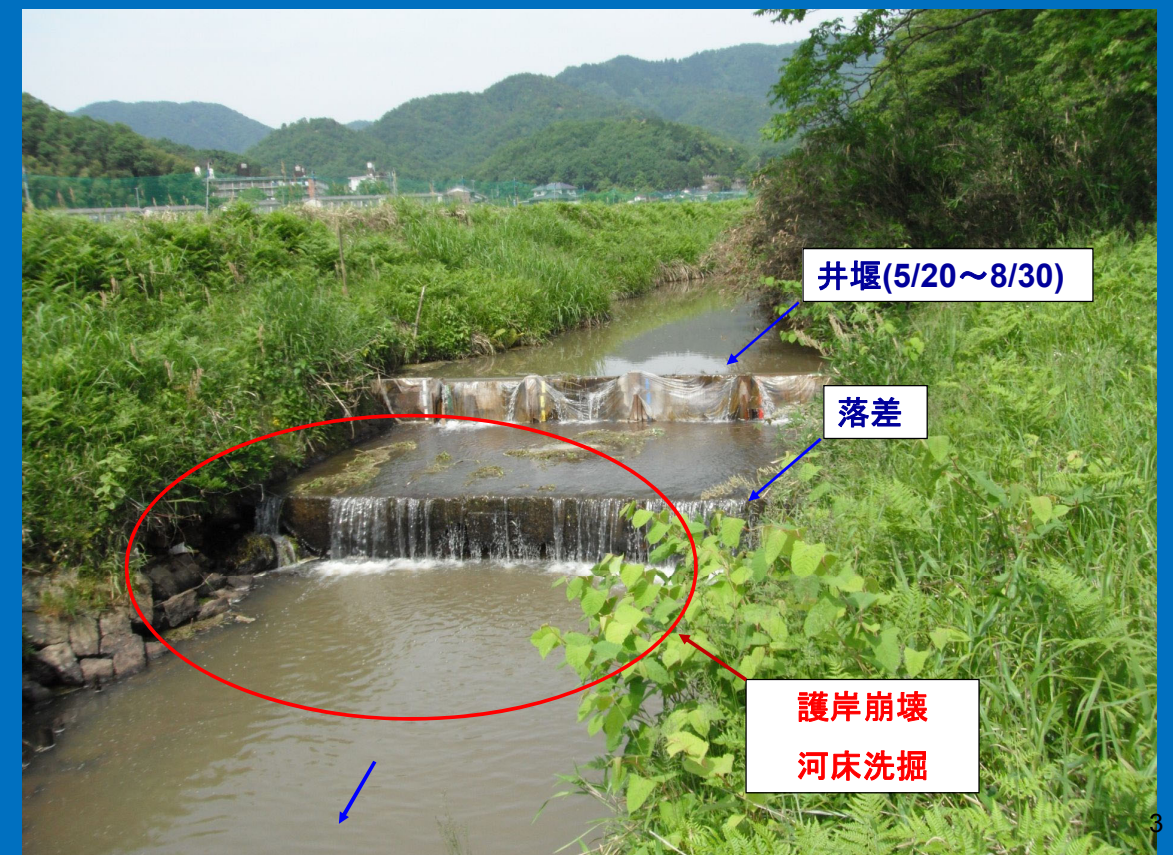
鎌谷川施工前写真(落差解消前)
