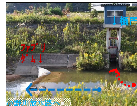
樋門とファブリダムの状況写真
