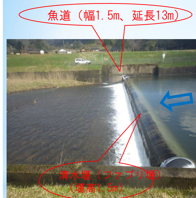
現況写真(堰本体) ※左岸より右岸を望む
