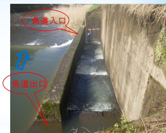
現況写真(魚道) ※上流より下流を望む
