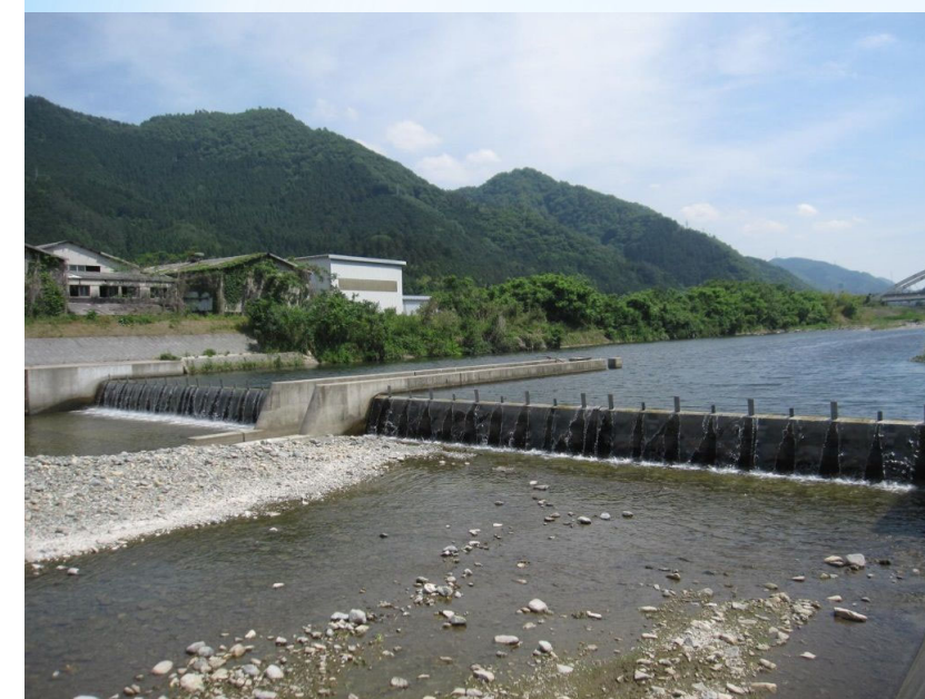
円山川水系円山川 中井・長屋井堰 (朝来市新井)
