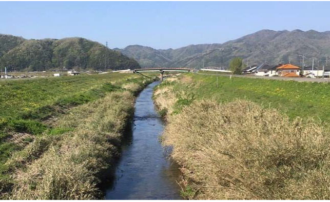
栃江橋下流（H30. 4）
