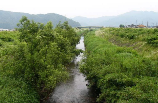
栃江橋下流（H16. 6）
