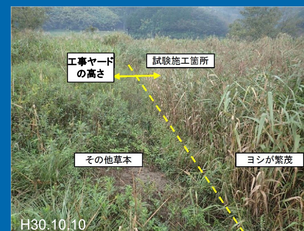
工事ヤードの高さと試験施工箇所の状況
