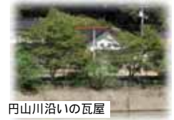
円山川沿いの瓦屋
