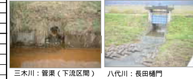
三木川：管渠（下流区間） 八代川：長田樋門
