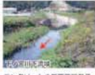
鎌谷川取水樋門
