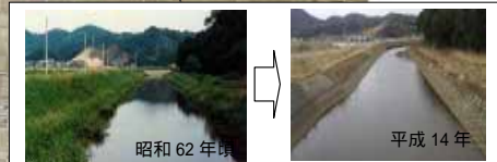
中江井堰上流 上流部は改修工事でエコトーン帯が消失している
