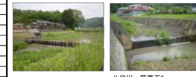
八代川：堰 八代川：落差工5
