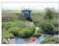
八代川取水樋門
