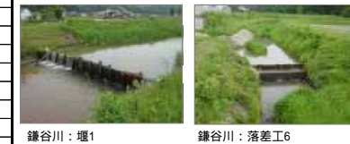
鎌谷川：堰1 鎌谷川：落差工6
