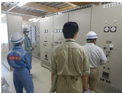
図 5.3 樋門等機械・電気設備の点検
