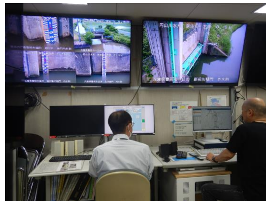
図 6.5 樋門の遠隔操作の実施状況
