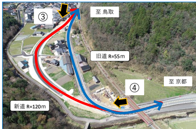
【工事途中 (R3.3.31)】
