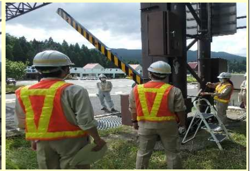
手動(停電時)による遮断機の操作
