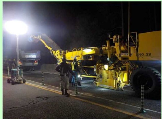
舗装修繕工事
