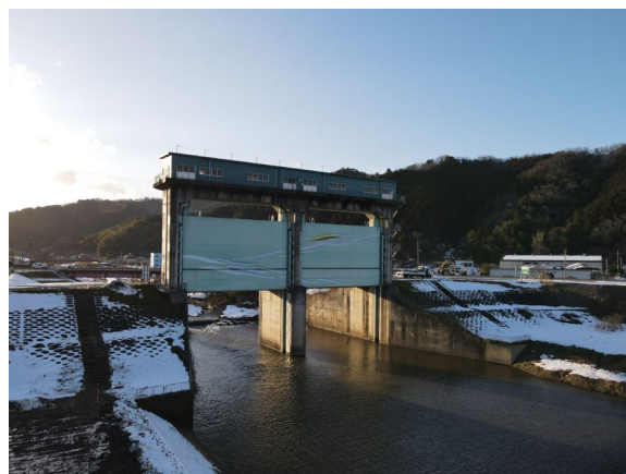
ワイヤロープ復旧完了（令和7年2月）
