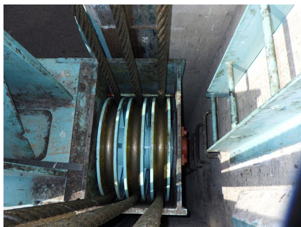
ワイヤロープの復旧状況（令和7年2月）
