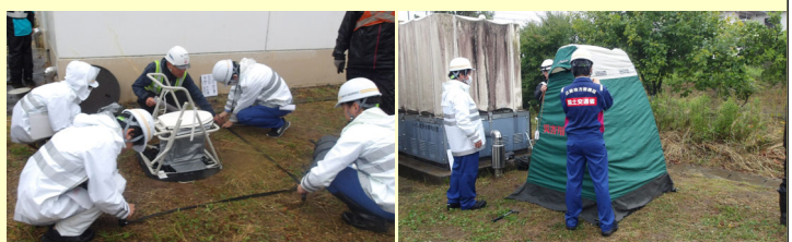
仮設トイレの組立
