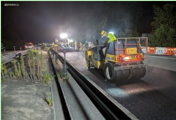
舗装修繕工事
