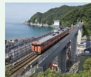
余部橋梁（提供：香美町）
