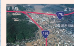
写真② 国道178号及び426号の浸水状況（H16.10撮影）
