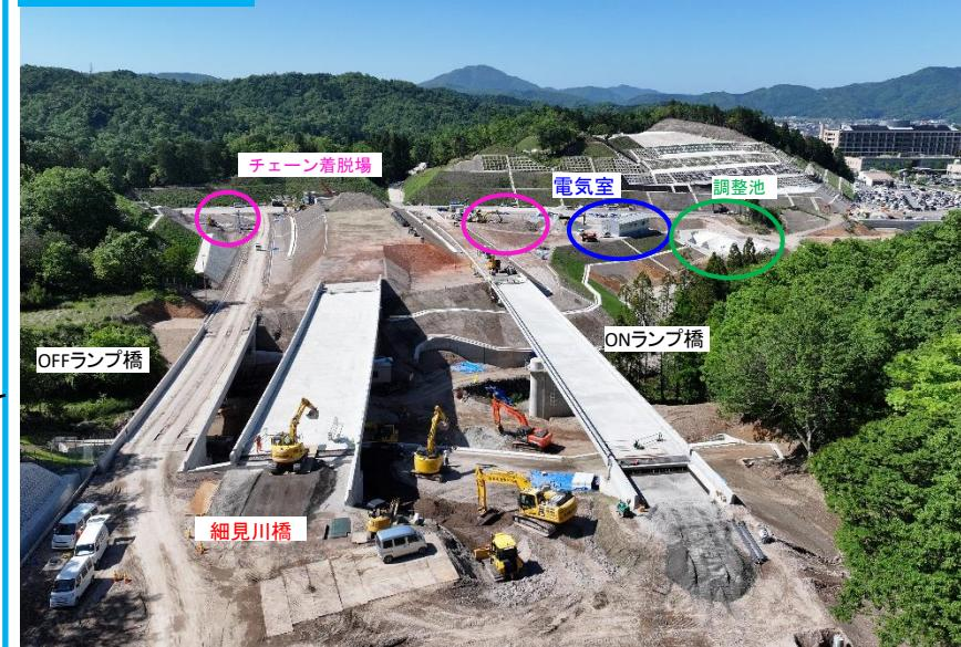
現在は、橋梁下の重力式擁壁、ONランプ橋の踏掛け板の施工を行っています。
