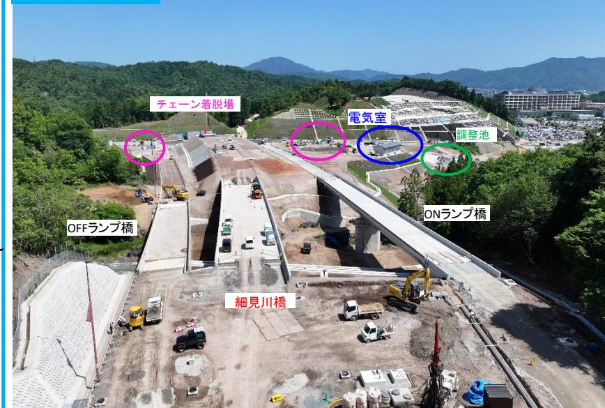
ONランプ橋の踏掛け板の施工が完了し、現在は、橋梁下の重力式擁壁の施工、仕上げの舗装工事を行っています。今後は、ONランプのチェーン着脱場の路床掘削を行う予定です。
