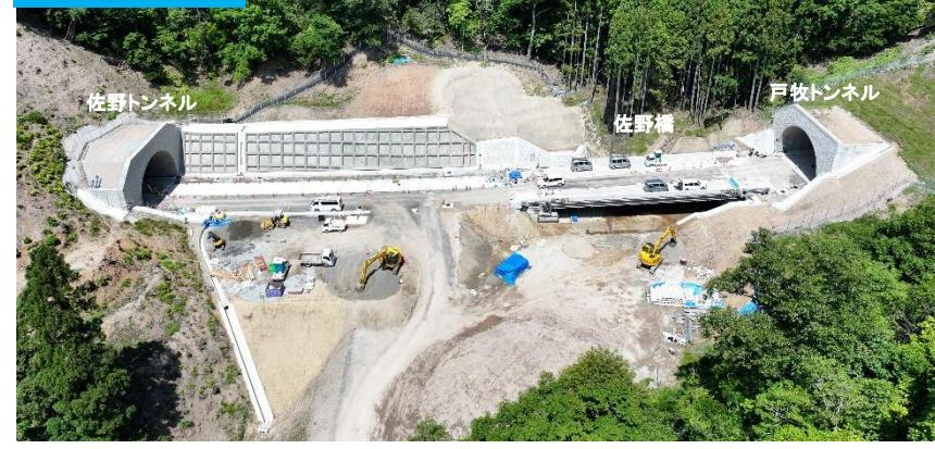
現在は、無散水融雪設備の放熱器の施工を行っています。今後は、佐野橋下の掘削を行う予定です。
