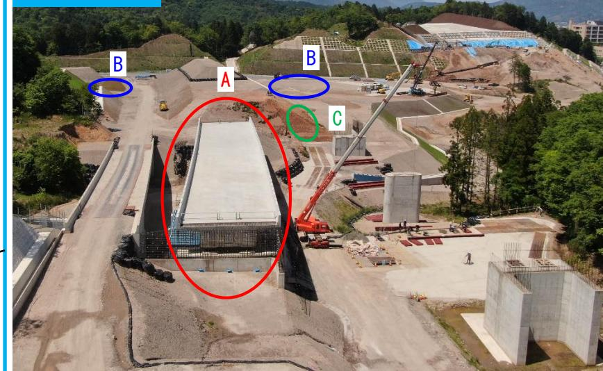
細見川橋(A)の上部工事が完成しました。また、北側ではチェーン脱着場(B)やONランプ橋部(C)の路体盛土工、路床盛土工が完了しました。現在はONランプ橋部(C)の上部工の架設準備を行っております。
