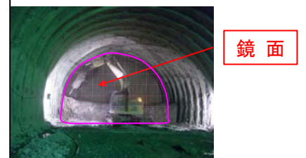
【参考】鏡面：トンネル掘削時の正面の土の部分
