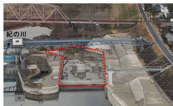
岩出狭窄部は川幅が狭く、貴志川の合流により土砂が堆積しやすく、紀の川で治水上のネックとなっていました。そこで、平成28年度から令和2年度にかけて、岩出狭窄部の河道掘削と拡幅水路整備を実施しました。
