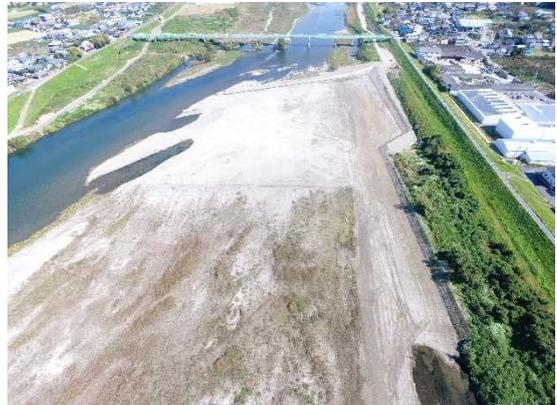
藤崎狭窄部は川幅が狭く、土砂が堆積しやすく、紀の川で治水上のネックとなっています。そのため、藤崎頭首工(堰)付近に河川の拡幅を行うとともに、堰上流部の河道掘削を行う予定です。令和元年から堰上流の河道掘削に着手しています。
