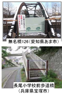
通行止め橋梁
