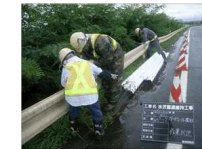
＜防護柵の取替＞
