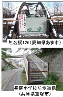
通行止め橋梁
