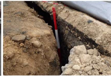
法肩部クラック
