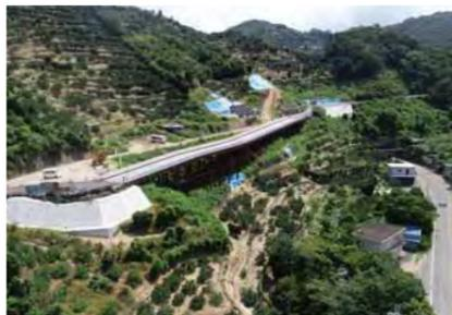
1号トンネル・3号橋を施工するために、工事用の進入路を整備しています。
