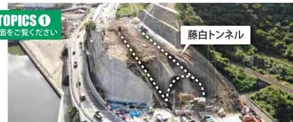
国道42号を2車線から4車線に拡幅するため、国道42号にある藤白トンネルの撤去を進めています。
