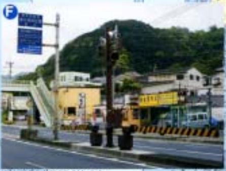
通行規制区間(終点) 和歌山北港
