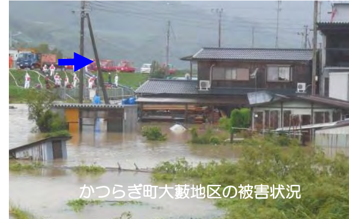
■H25年9月台風18号洪水 おおやぶ かつらぎ町大藪地区の被害状況
