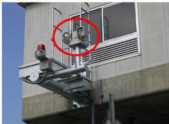
図 4.4-2 樋門への河川管理用カメラ設置状況
