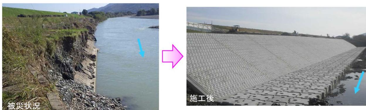
図 6.1-2 護岸の復旧工事
