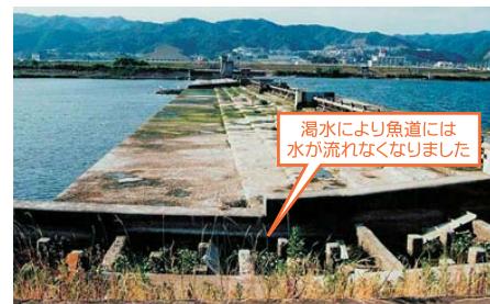
新六ヶ井堰の魚道 (平成6年7月)
