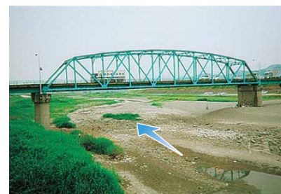
貴志川 諸井井堰下流 (平成14年6月)
