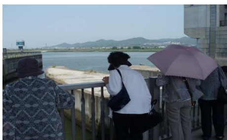
階段式魚道を上から見てみる
