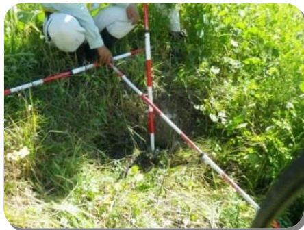
▲堤防の陥没を発見
