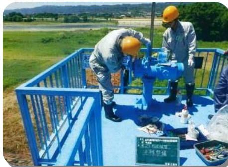
▲樋門の開閉機の点検
