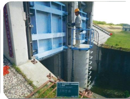
▲樋門のゲートの点検
