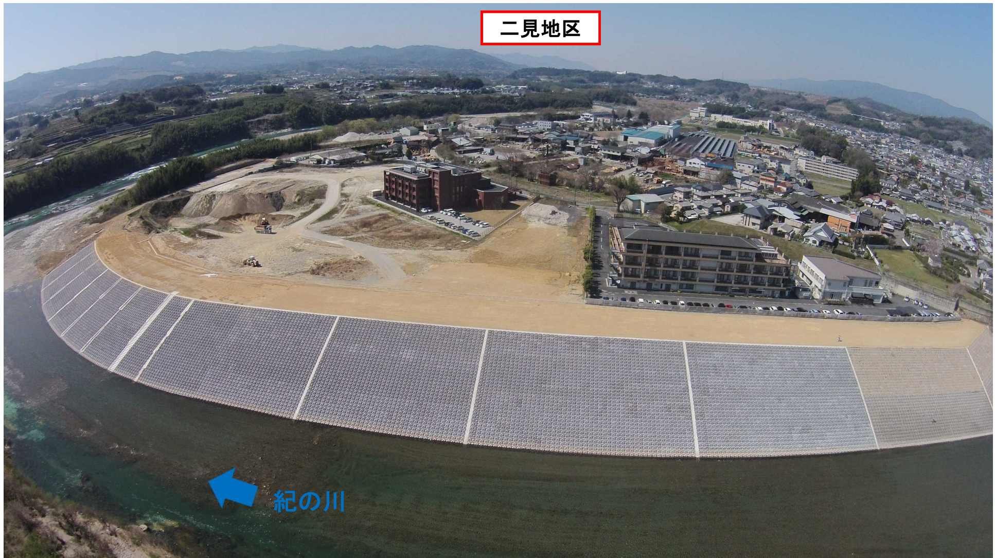
二見地区築堤状況
