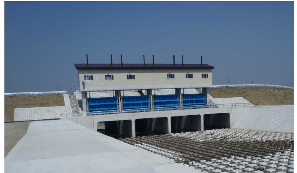
樋門完成状況 (H27.4月)
