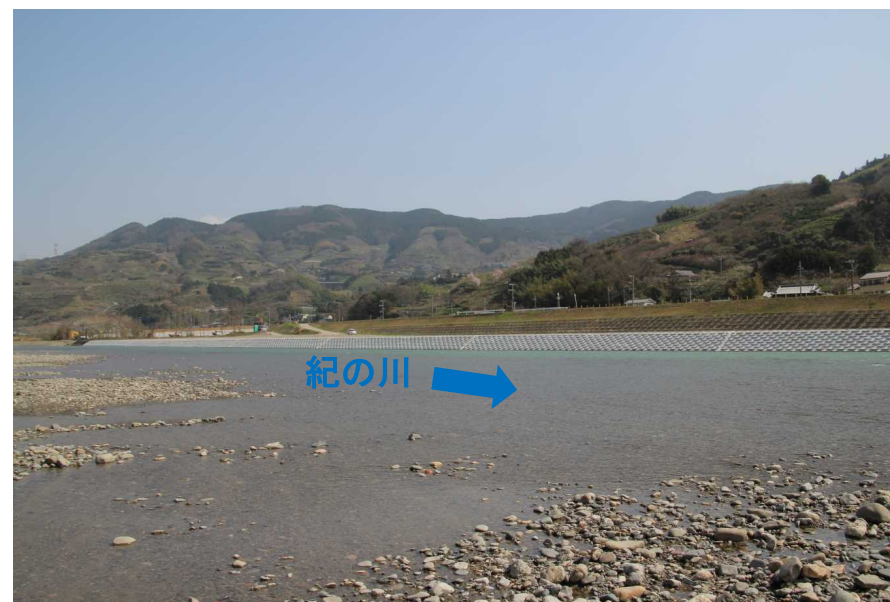
兄井地区完成状況(H27.4月)
