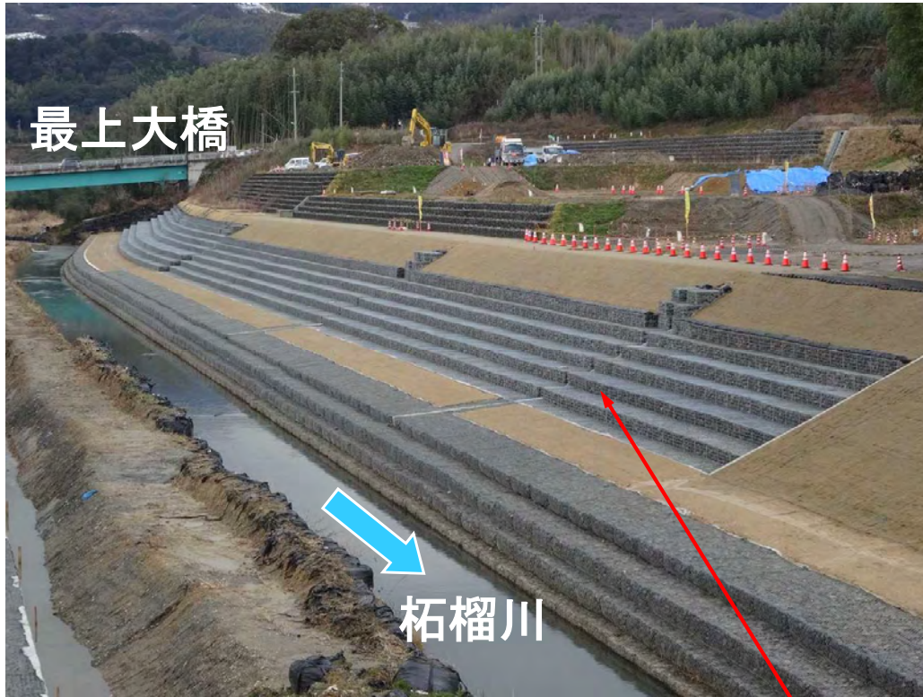
柘榴川施工状況
