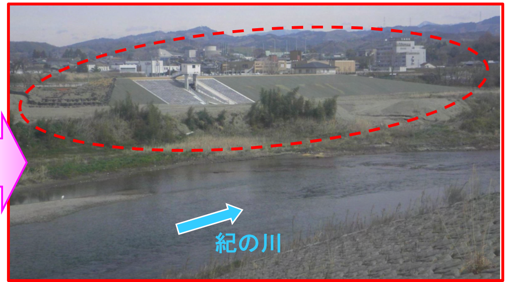
野原西地区施工後
