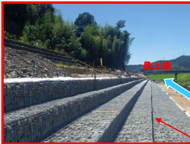
柘榴川左岸施工状況
