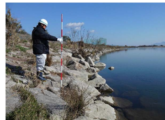
▲護岸点検の様子
