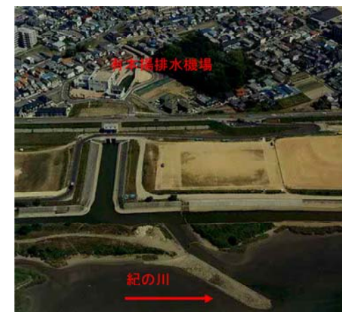
▲有本揚排水機場
