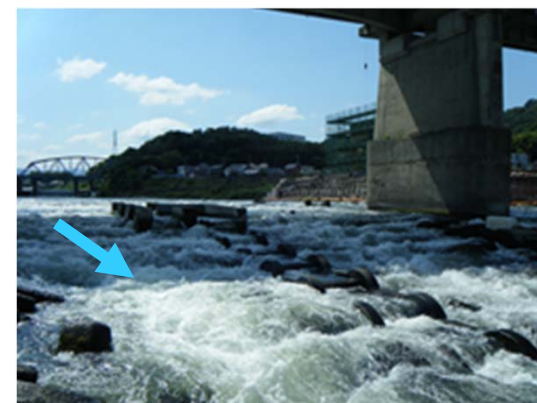
▲岩出橋 階段式魚道
