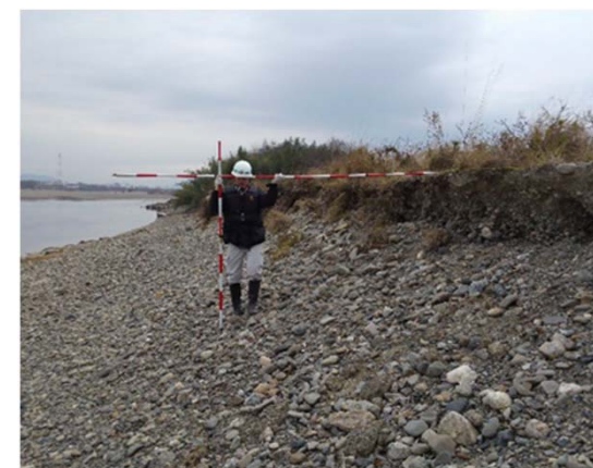
▲河岸点検の様子
