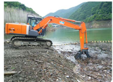
▲引き上げ状況
