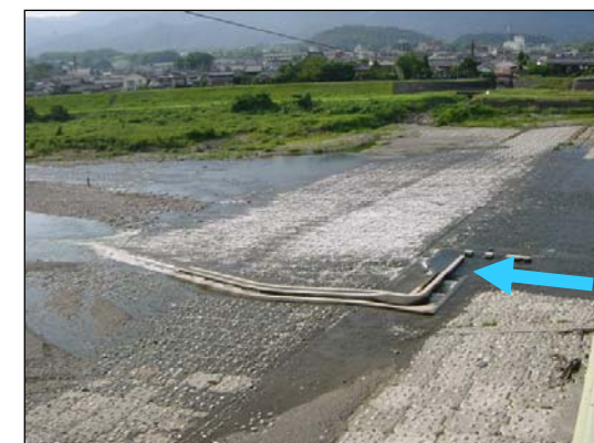
▲大川橋 階段式魚道
