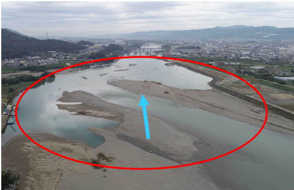
施工前(令和元年10月)
