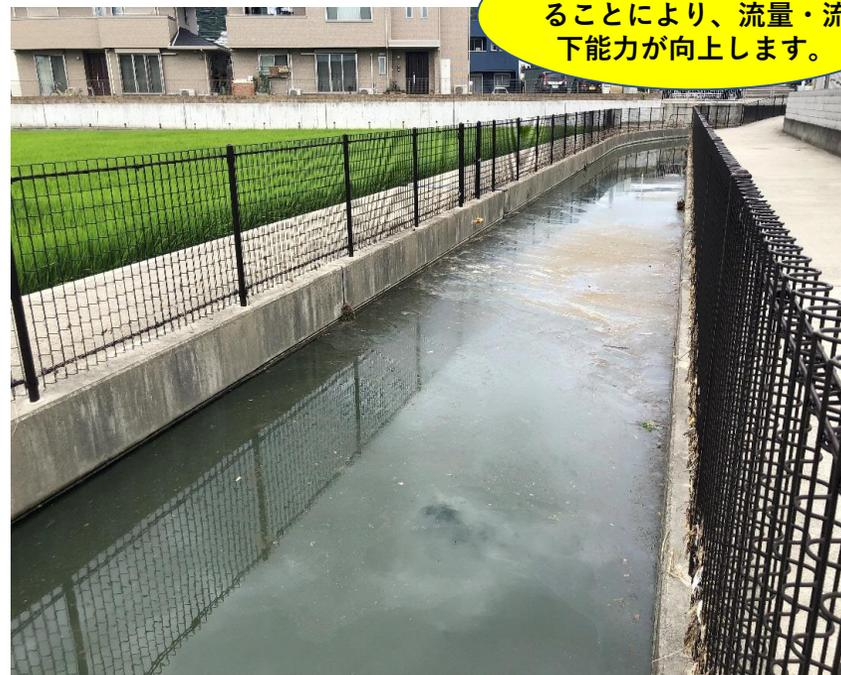
水路断面を拡張し整備することにより、流量・流下能力が向上します。
