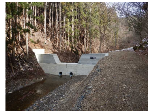
溪間工事の例
