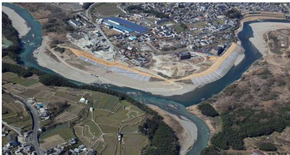
築堤護岸（野原西地区・二見地区）
