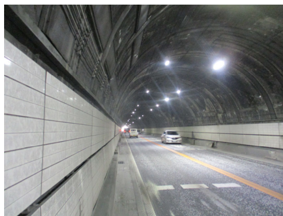
塩津第一トンネル
