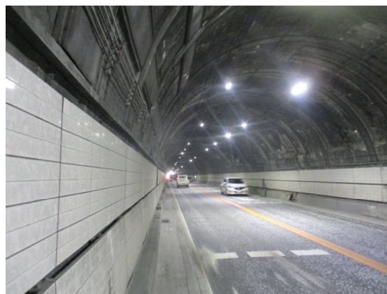
塩津第一トンネル
