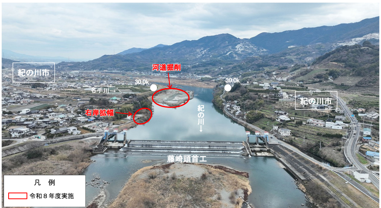
河道掘削（藤崎地区）
