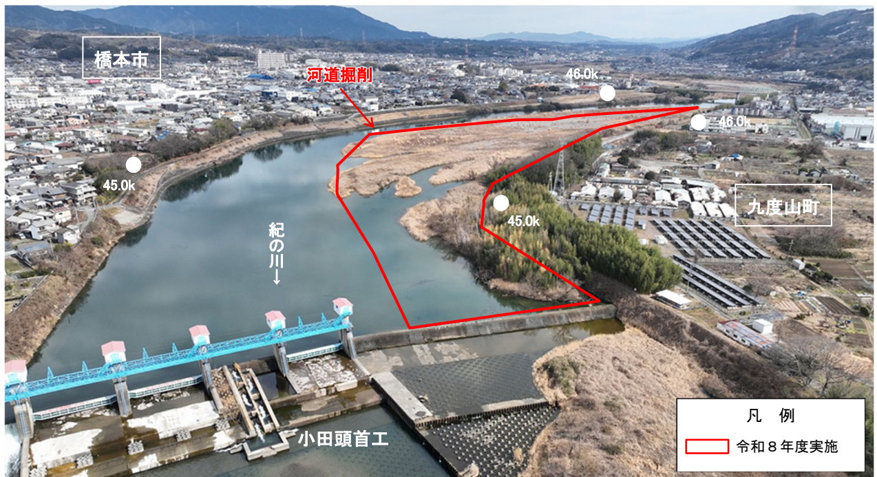
河道掘削（九度山地区）
