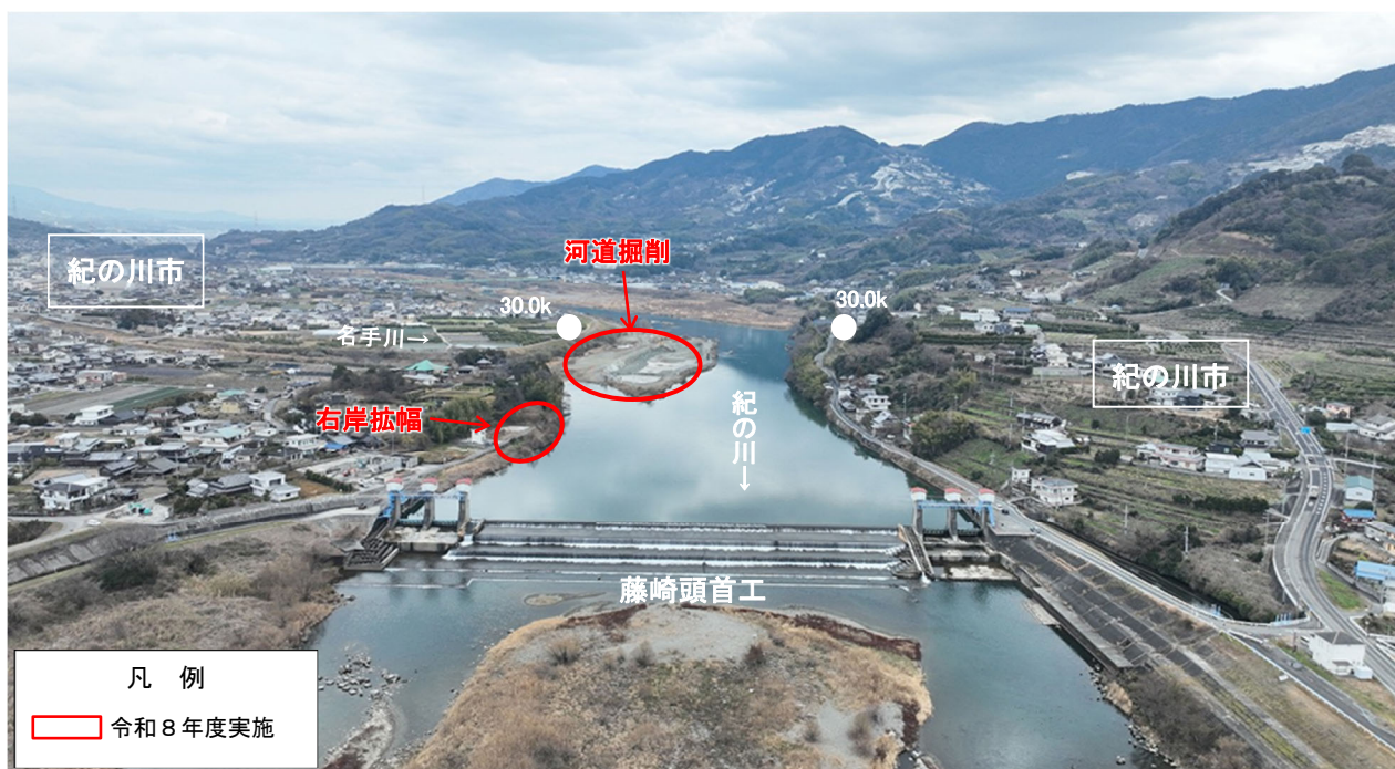
河道掘削（藤崎地区）
