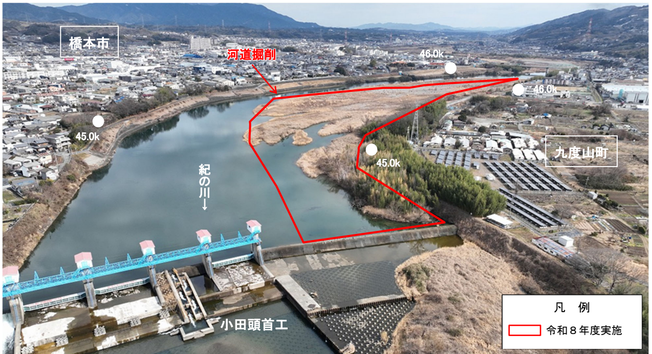
河道掘削（九度山地区）
